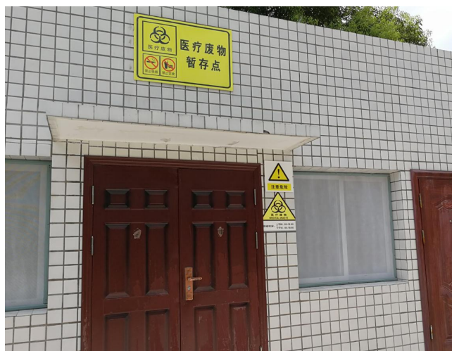
图 7-3 现有医疗废物暂存间现状图
