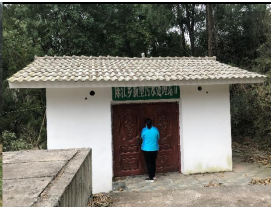
陈江污水处理站 II（南）
