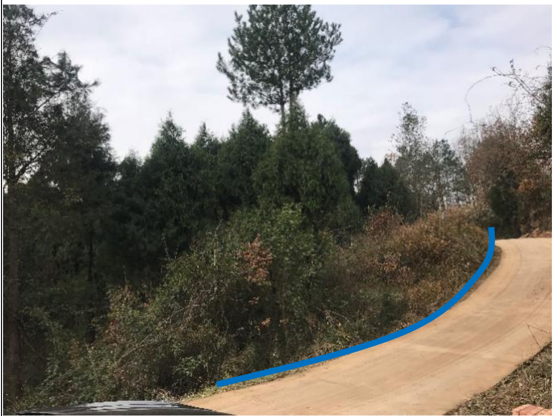
沿线污水收集管网
