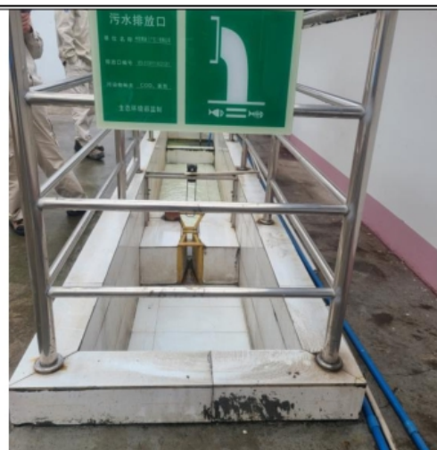
污水处理站排放口
