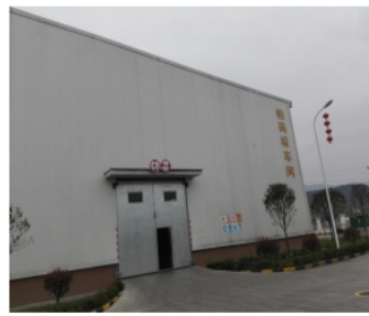
⑤粕码垛车间
