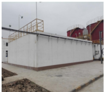
⑦污水处理站
