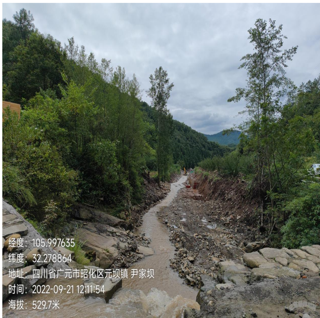
图 5.1-7 拣银岩沟防洪堤施工现场概况图
