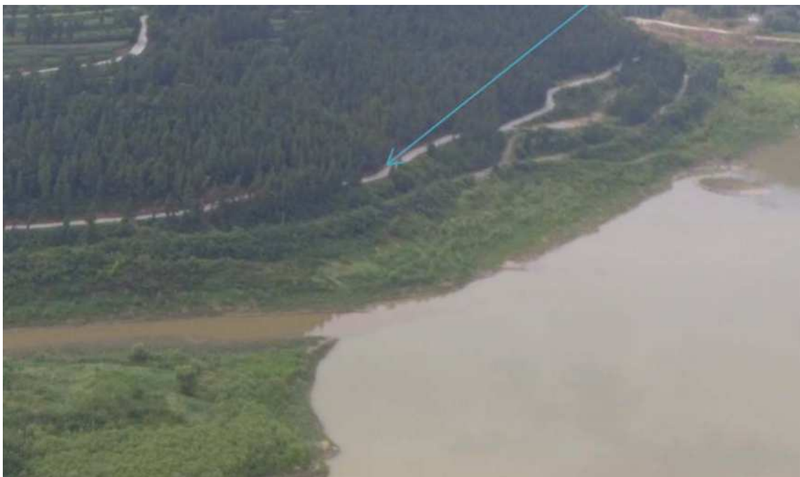
图 1-8 龙江寺大桥桥位实景图
