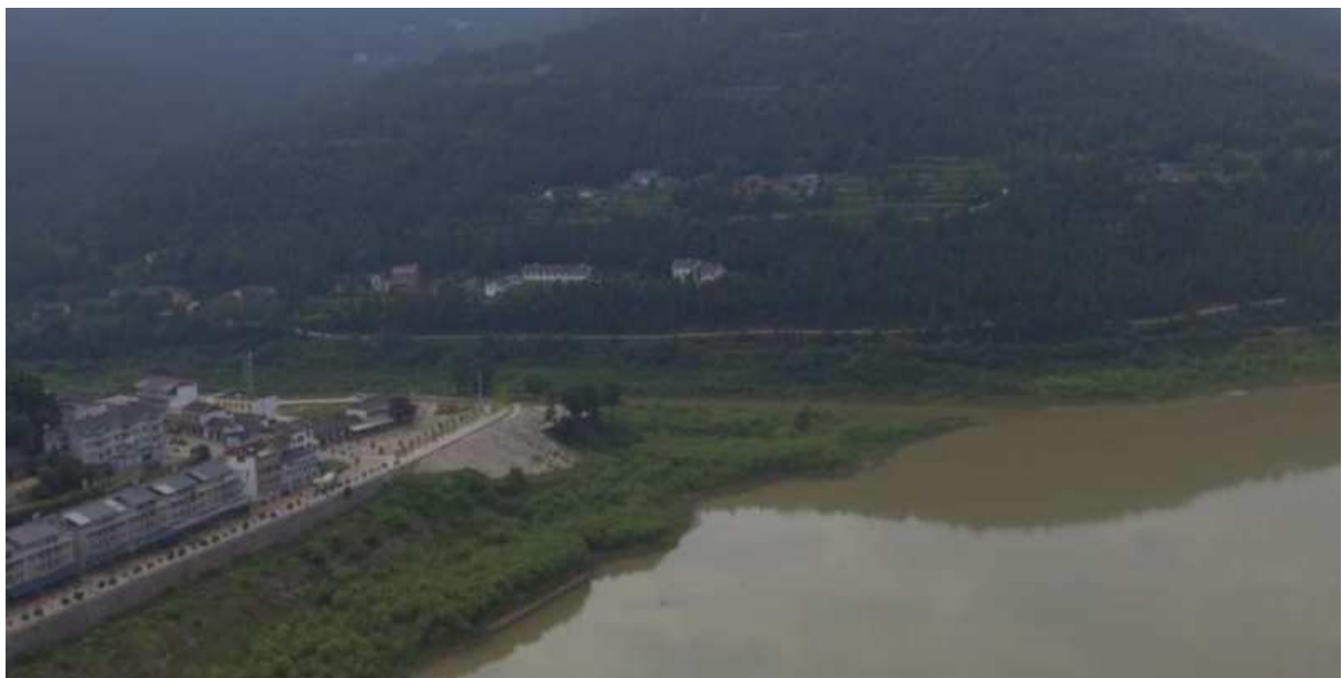
图 1-4 射箭河大桥桥位实景图
