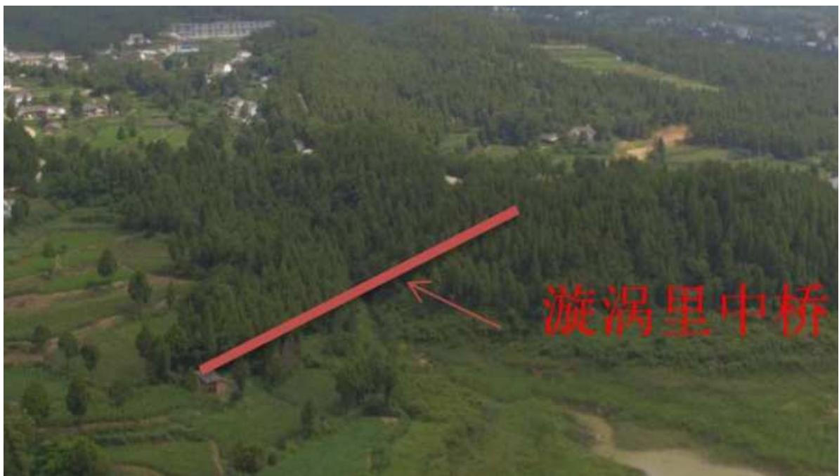
图 1-6 漩涡里中桥桥位实景图
