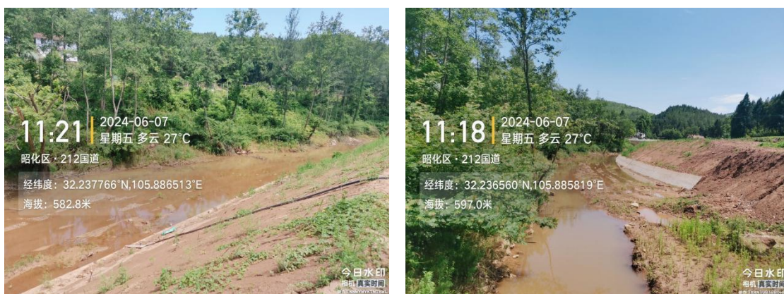
现场调查时现状
