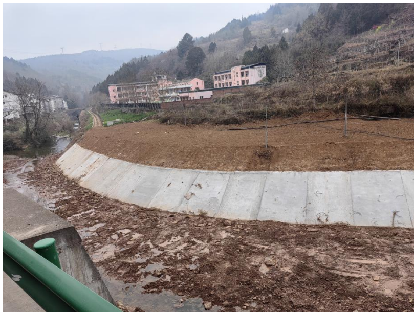
已建成紫云小学段（钢筋砼面板护坡）
