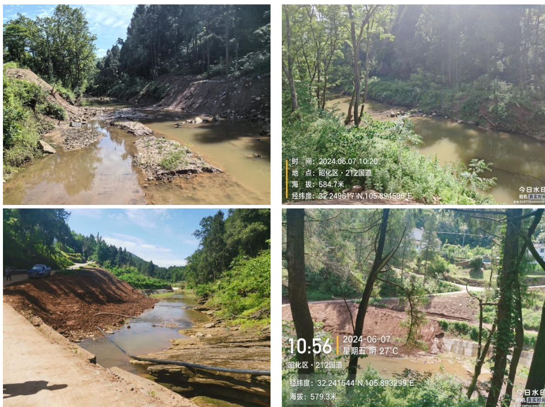
现场调查时现状
