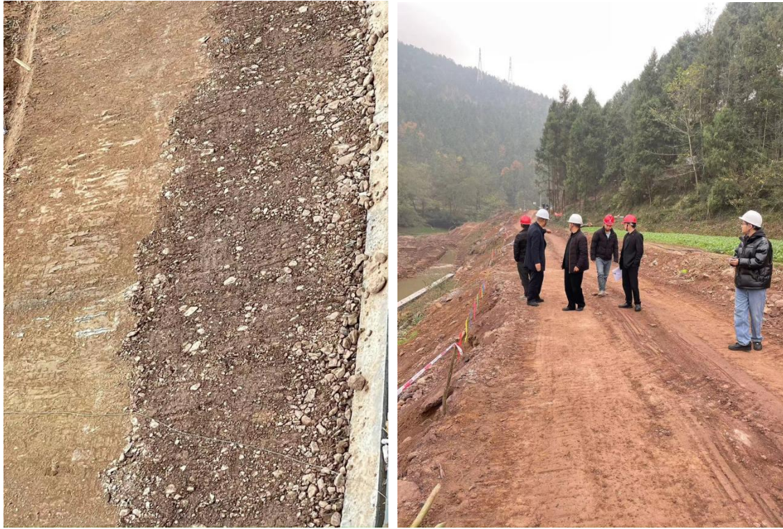
施工便道（部分泥结石路面）
