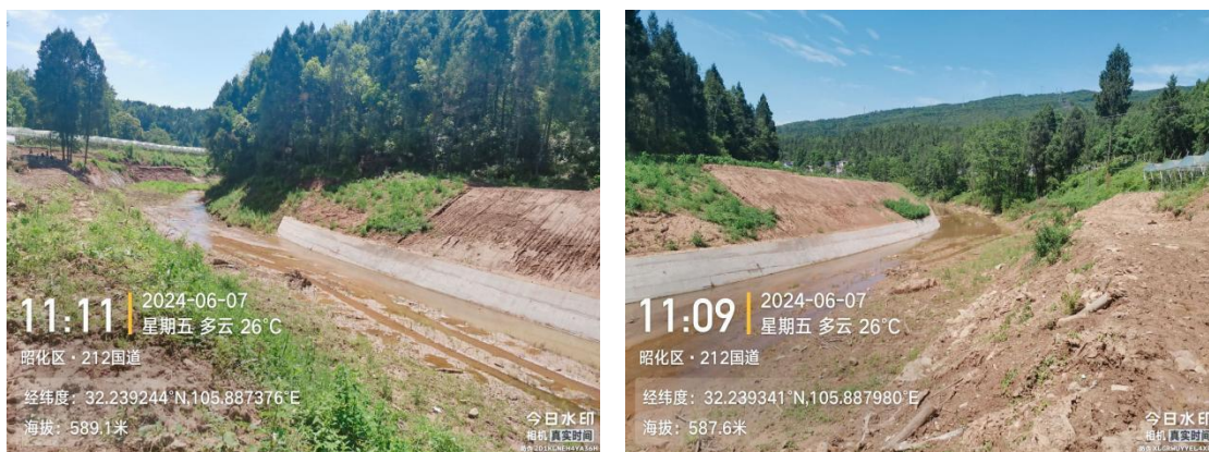
现场调查时现状
